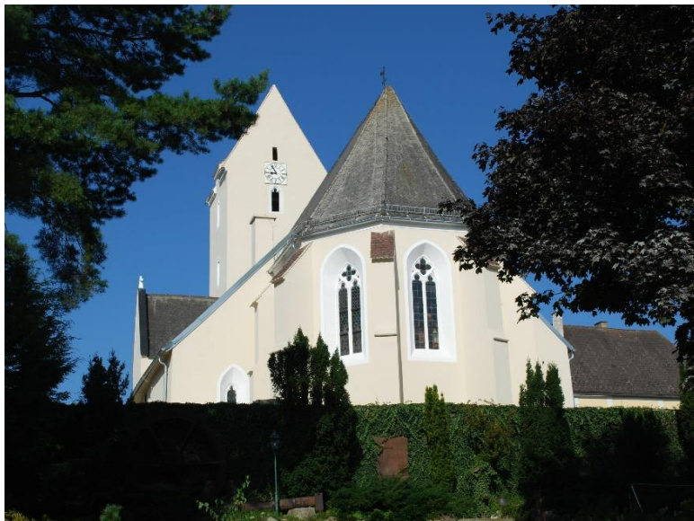
Pfarr- und Wallfahrtskirche Mariä Himmelfahrt (Ostansicht)
