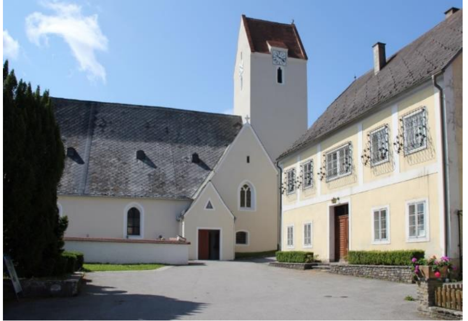
Pfarr- und Wallfahrtskirche Neukirchen am Ostrong (Nordansicht)
